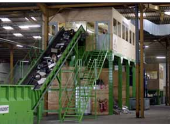
L'entreprise Juratri (Perrigny, 39) a inauguré en septembre 2012 sa plateforme de recyclage des déchets électriques et électroniques Trivolution.
